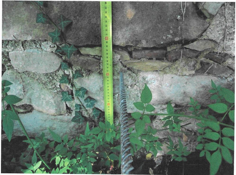
Le trou de sondage est réalisé jusqu'à 15 cm de profondeur.
